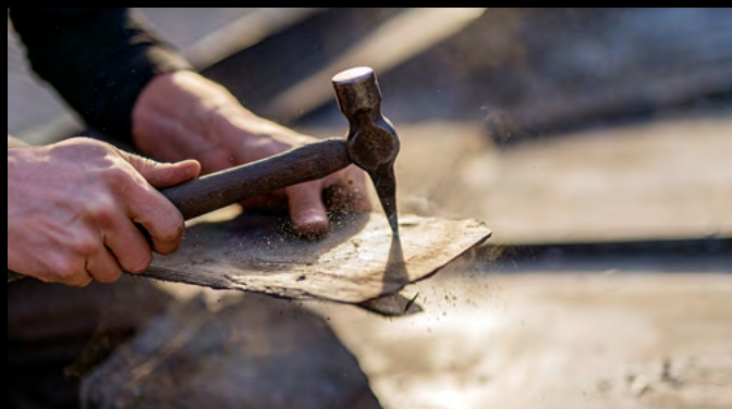
Nya hål görs i en del av skifferplattorna då de gamla nöts ut.
