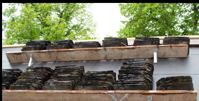
Det mesta av skiffern som plockats bort staplas snyggt för att sedan monteras tillbaka.
