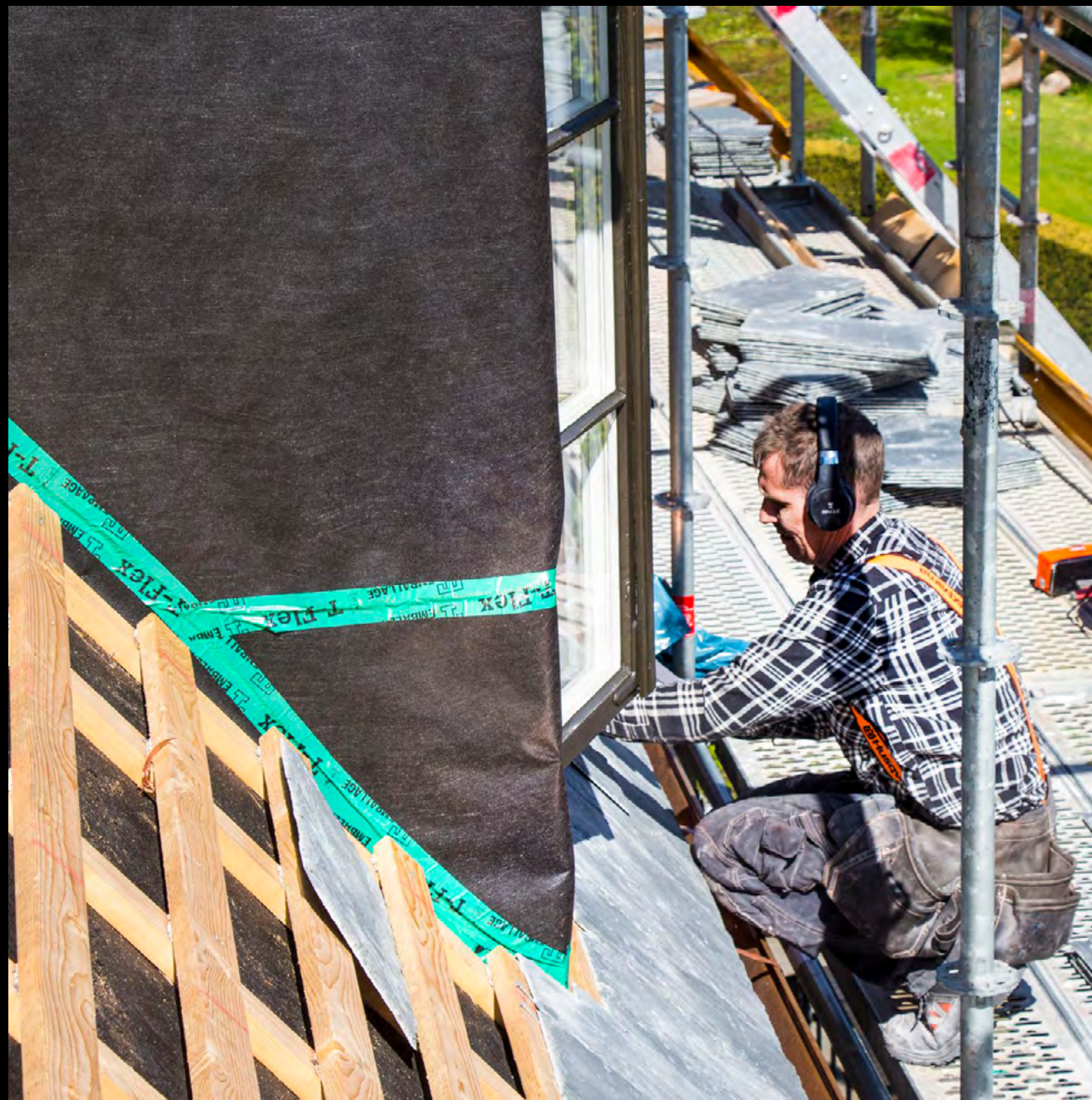
Nya hål görs i en del av skifferplattorna då de gamla nöts ut.
